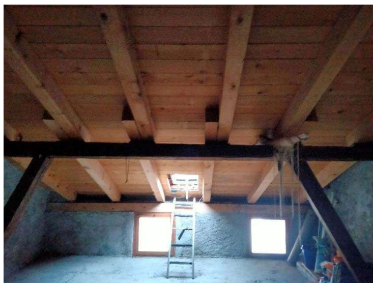
Sottotetto con accesso da botola su disimpegno
